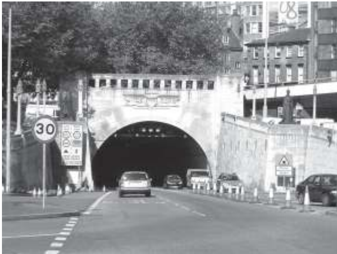
Lối vào tại Liverpool của hầm Queensway
