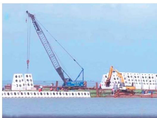
Ứng dụng giải pháp bê tông cốt phi kim nhằm tăng cường tính bền vững cho các công trình kè chắn sóng ven biển ở khu vực Đồng bằng sông Cửu Long dưới tác động của biến đổi khí hậu.
